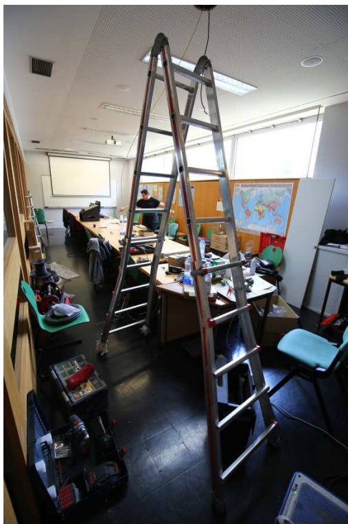
La salle Interprétation pendant les travaux
